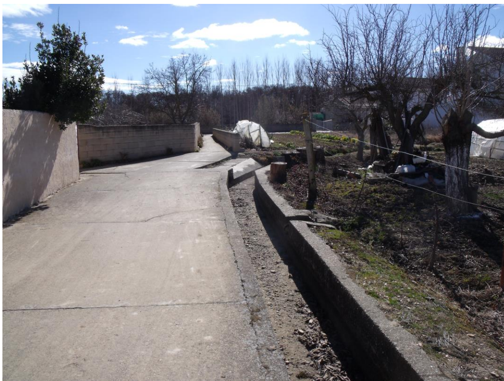
Dirección Sur de calle y conexión con la calle Real
